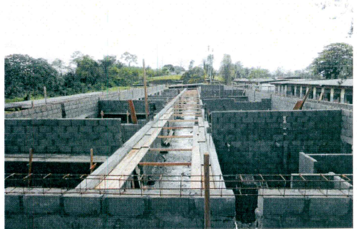
Der Neubau der Maternité im April 2013
