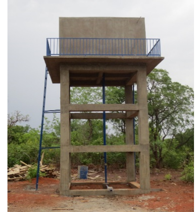
Das volle Wasserreservoir
